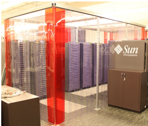
Kaltgangeinhausung aus Plastiklamellen für alle Arten von Standalonegeräten. Die Bodenplatten vor den Servern sind durch Gitterplatten ersetzt. Das Klima im Kaltgang, also vor den Servern, entspricht so weitgehend dem Klima im Doppelboden
